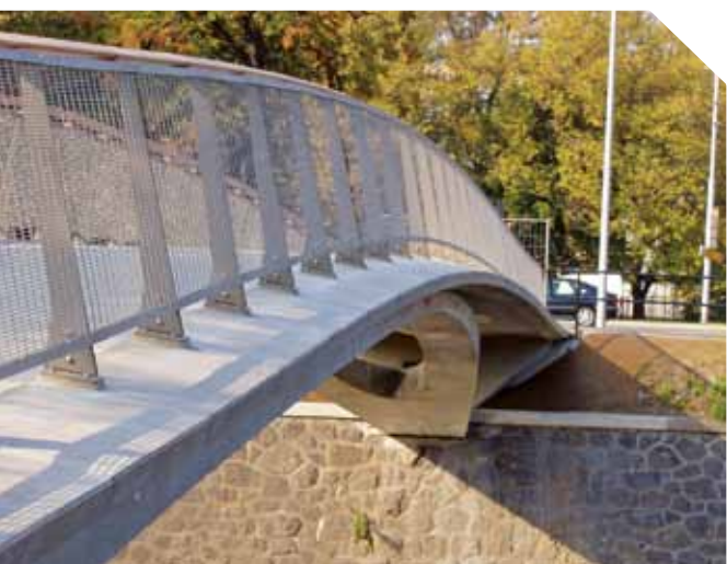
Lávka přes Svratku
