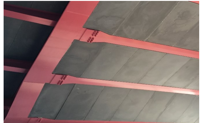
Pohledová strana desky po montáži na ocelovou konstrukci
