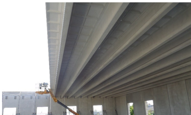
Ukázka interiéru při výstavbě
